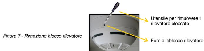
Figura 7 - Rimozione blocco rilevatore
