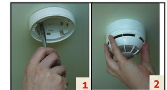
Figura 5 - Collocazione del rilevatore
